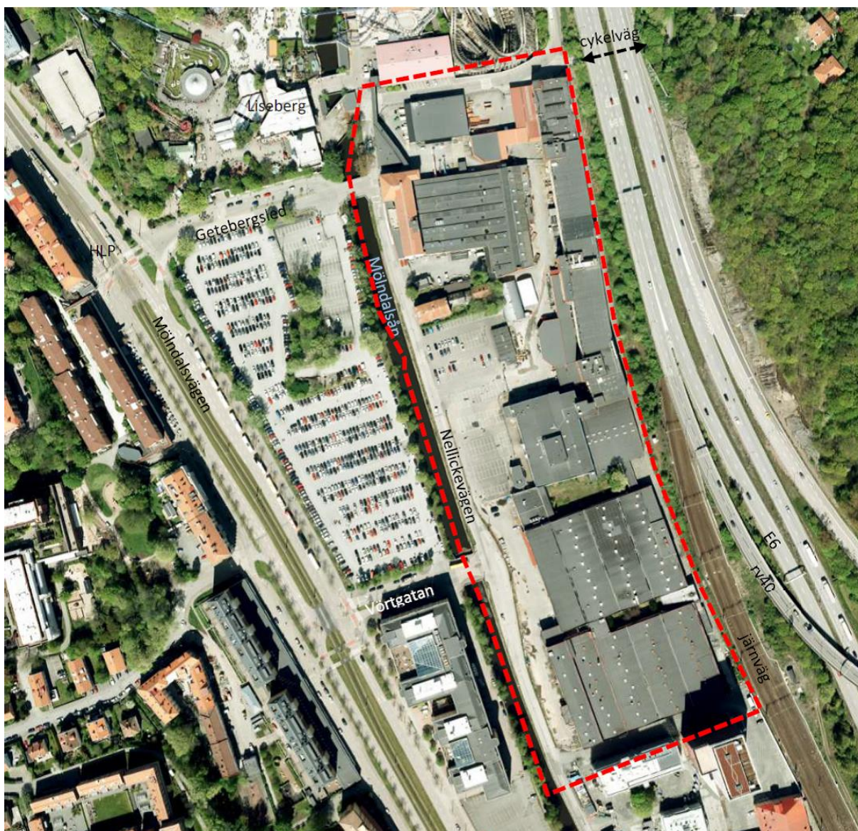
Figur 5. Karta över planområdet. En del av byggnaderna är idag rivna för att lämna plats åt en parkeringsplats, se Figur 12.
